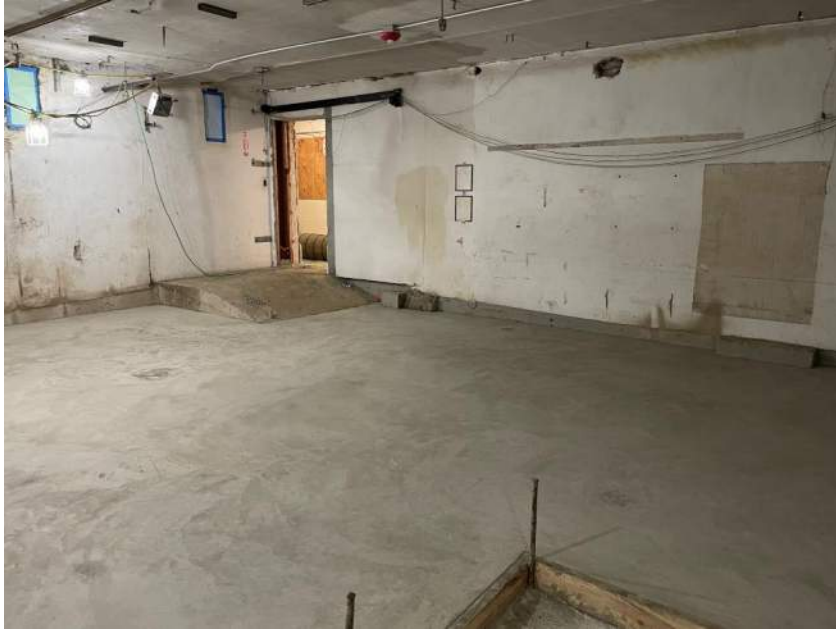
CHHS – Boiler room slab pour back
