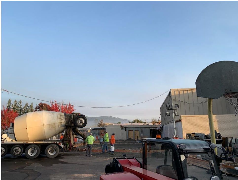
Stem Wall Concrete Pour at Science/Art Wing
