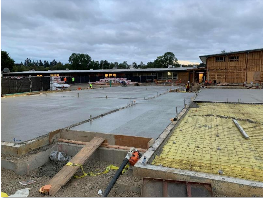
New Addition Slab Pour
