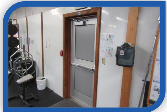
New Exterior Door
