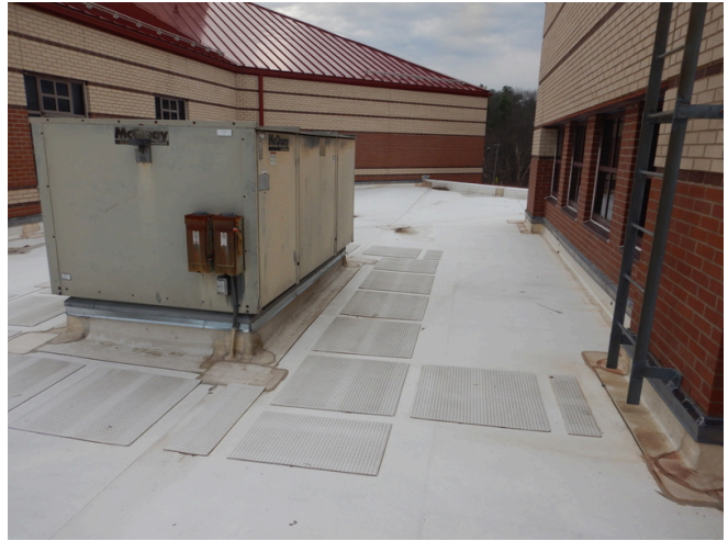
Gym: TPO membrane.
