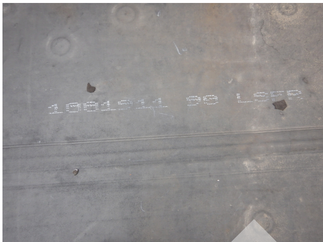
EDPM roof membrane.
