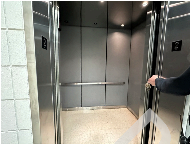
Elevator cab interior.
