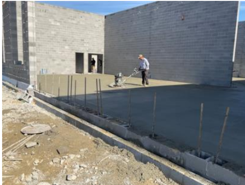
Slab pour in D wing
