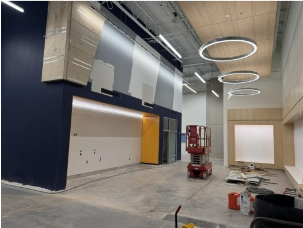
PA WING COMMONS AREA
