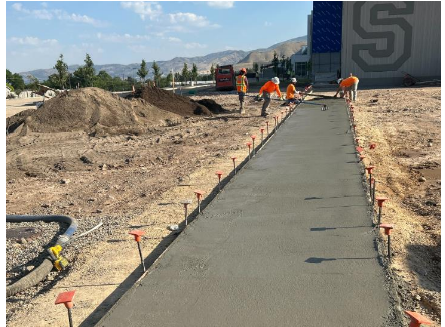
Concrete sidewalk pour
