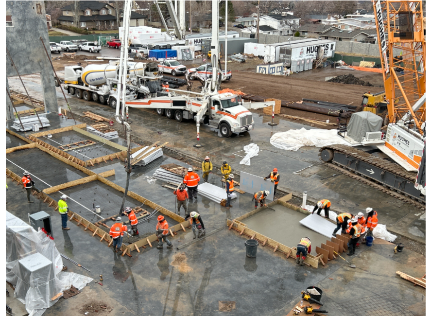
Tilt panel concrete pour
