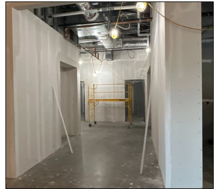
Drywall – Area A
