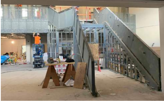
Commons and Main Stairwell
