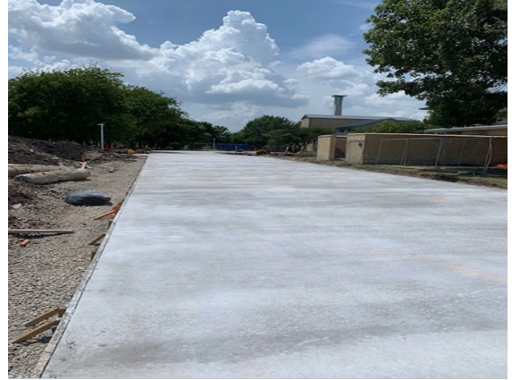
Fire Lane Poured
