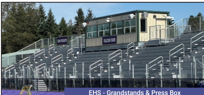
EHS - Grandstands & Press Box
